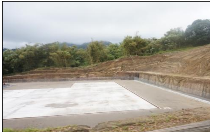
Geothermal Plant, La Soufrière Hills (Photo: S. Pike)
